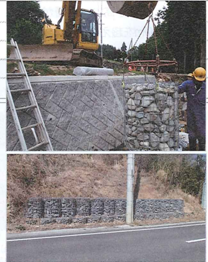
工事名/道路環境整備工事(田木工区)(埼玉県東松山市)、発注/埼玉県東松山県土整備事務所。正面面積26.1㎡、高さは2m
