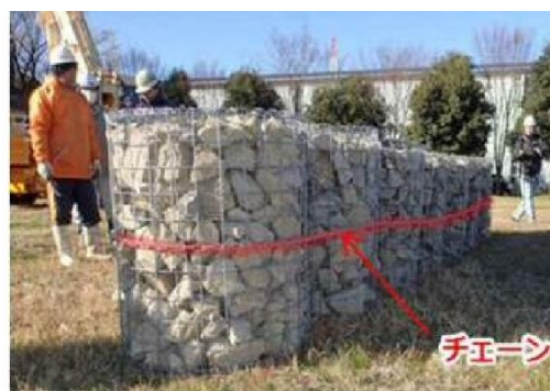
写真-2 チェーンによる構造の一体化 (京都大学防災研究所における検証実験)
