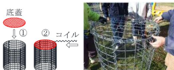
手順 (b) コイルにより底蓋を固定する。
