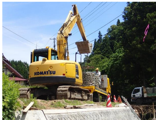
b) 荷下ろし状況
