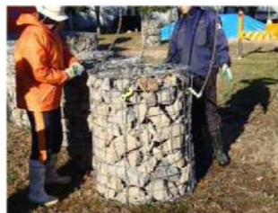
手順 (e) 石材上面を整え、コイルにより上蓋を取り付ける。
