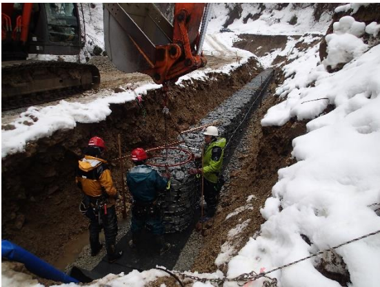
c) 設置状況
