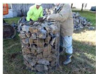
手順 (d) 円筒金網を逆さまにして石材（栗石）を入れる。
