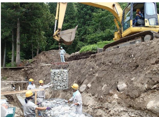
c) 吊り込み状況
