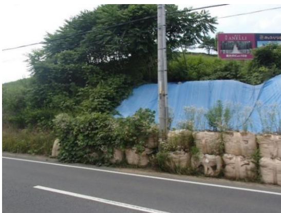
a) 施工前仮復旧状況
