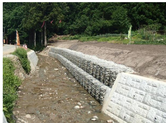
d) 完成状況
