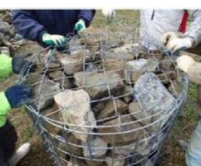
手順 (e) 石材上面を整え、コイルにより上蓋を取り付ける。
