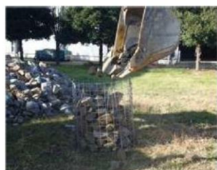
手順 (d) 円筒金網を逆さまにして石材（栗石）を入れる。
